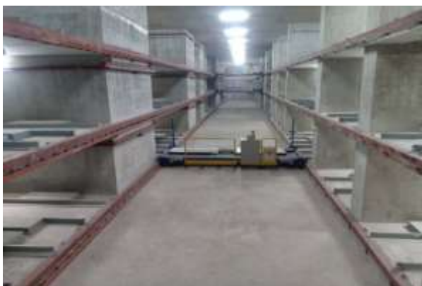
ที่จอดรถ ระบบจอดรถอัตโนมัติ จำนวน 232 ช่องจอด ชั้น 2-10
