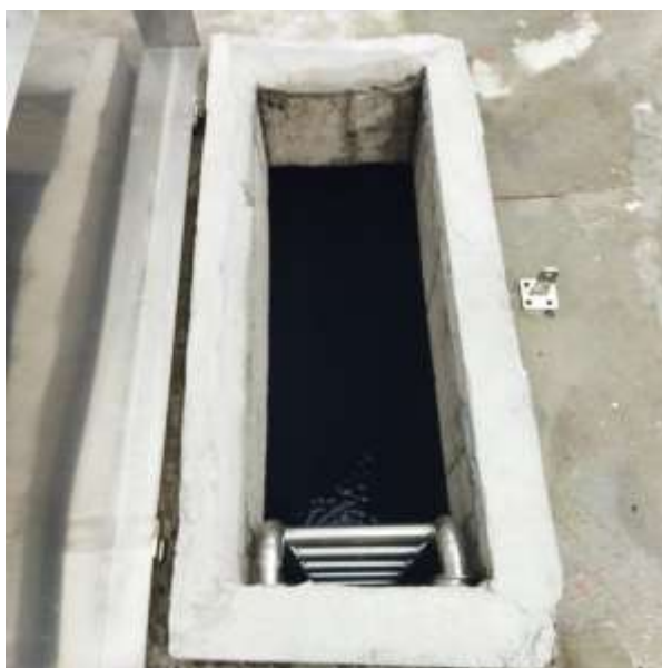
ภาพที่ 3.6.1 ถังเก็บน้ำชั้นดาดฟ้า อุบัติเหตุ-บริเวณ แท็งก์ 1 ขนาด 77.2 ลบ.ม
