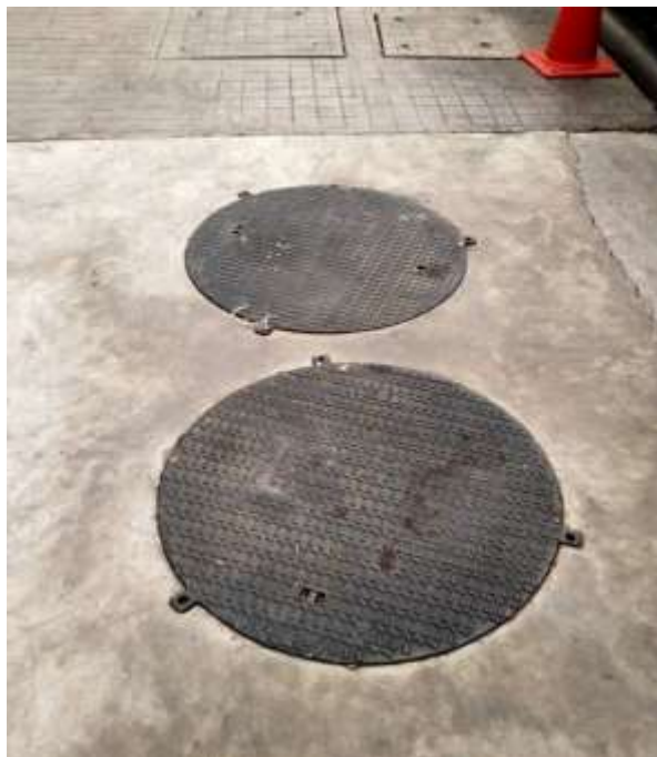
ภาพที่ 3.8.1 บ่อหน่วยรองรับน้ำฝนภายในอาคาร ขนาด 108 ลบ.ม จำนวน 1 บ่อ
